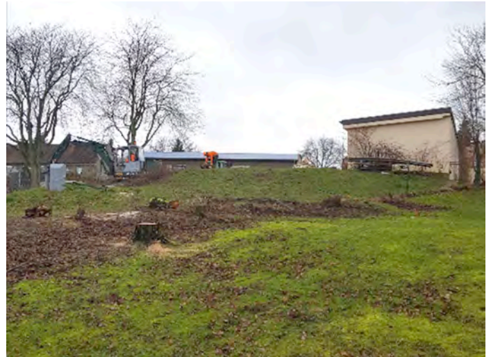
Rodewitz Rückschnitt der Bäume und Sträucher der Außenanlage des Kultur- und Begegnungszentrums
